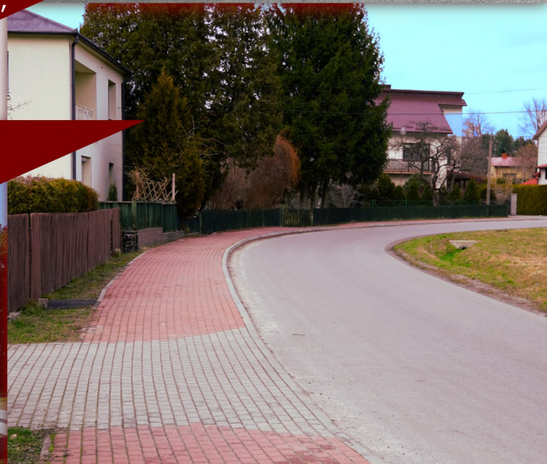
Przebudowa obiektu mostowego w Siedlance (na Grobli) 2022
