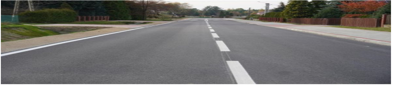
Zmodernizowano drogę powiatową Niwiska - Kolbuszowa
