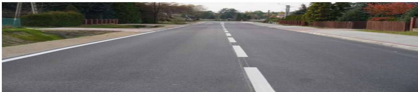
Zmodernizowano drogę powiatową Niwiska - Kolbuszowa
