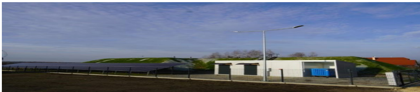
Nowa przepompownia wody w Kosowach
