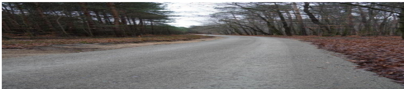
Przebudowany odcinek drogi gminnej w Hucinie
