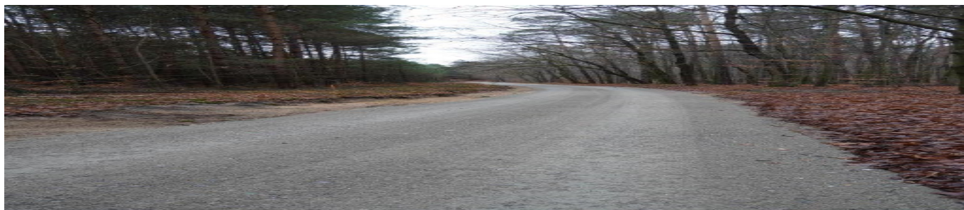
Przebudowany odcinek drogi gminnej w Hucinie
