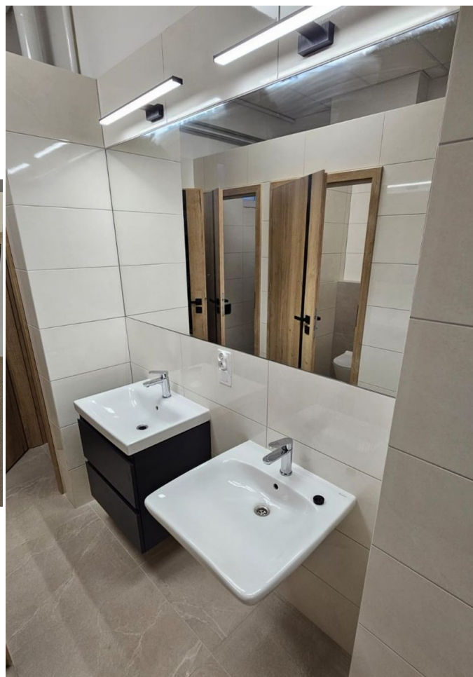
Modernizacja wewnętrzna budynku remizy OSP w Przyłęku (zaplecze kuchenne) - 137 375zł.
