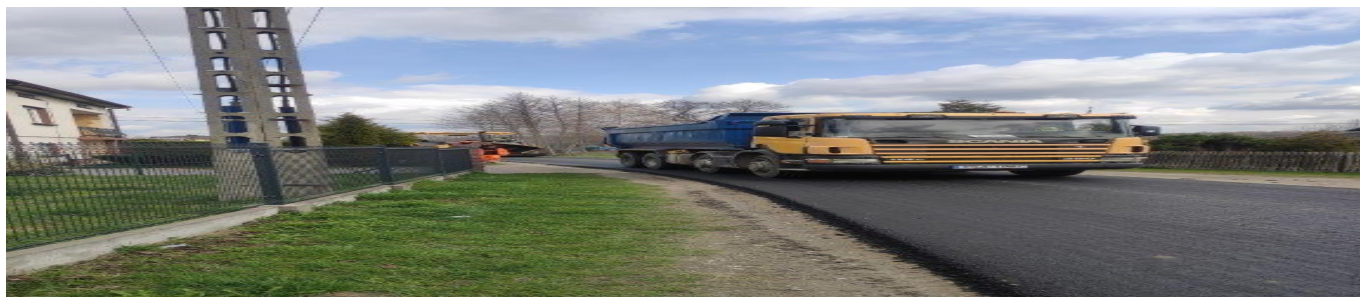
remont drogi Trzeźń
