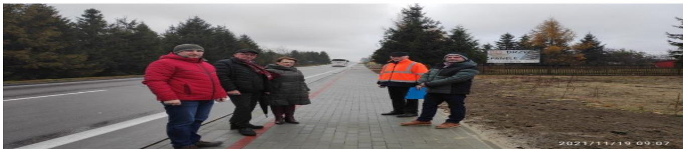
Budowa chodnika w miejscowości Przylęk
