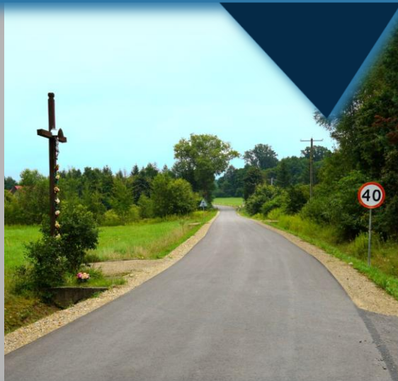
Modernizacja dróg: Trześń, Hucina, Niwiska
